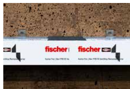
Installazione ultimata di FFB-VS con Multi Purpose Bracket.
